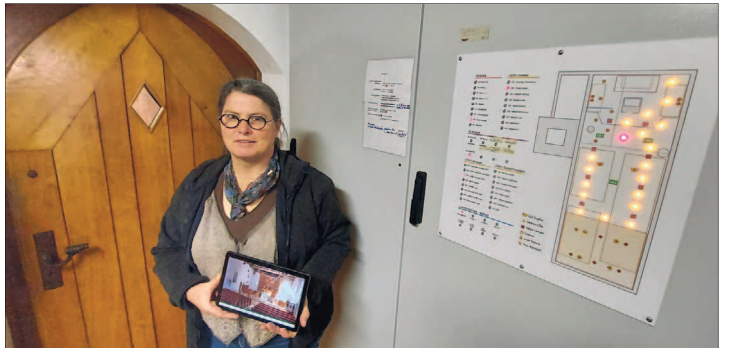
Friederike Rathmann ist Mesnerin. In der St. Michaelskirche steuert sie die Technik, Mikrofone, Licht, Heizung und Videokameras nun vom Tablet aus. Früher saß sie dafür in der Sakristei, konnte nur durch das kleine Fenster in der Tür hinausschauen. Nun kann sie im Kirchenraum Platz nehmen und hat trotzdem alles im Griff. Analog lässt sich alles aber auch noch von einer Schalttafel aus bedienen. FOTOS: FISCHER
