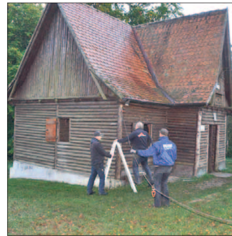
Die Bolberghütte wird gerade gezogen.
