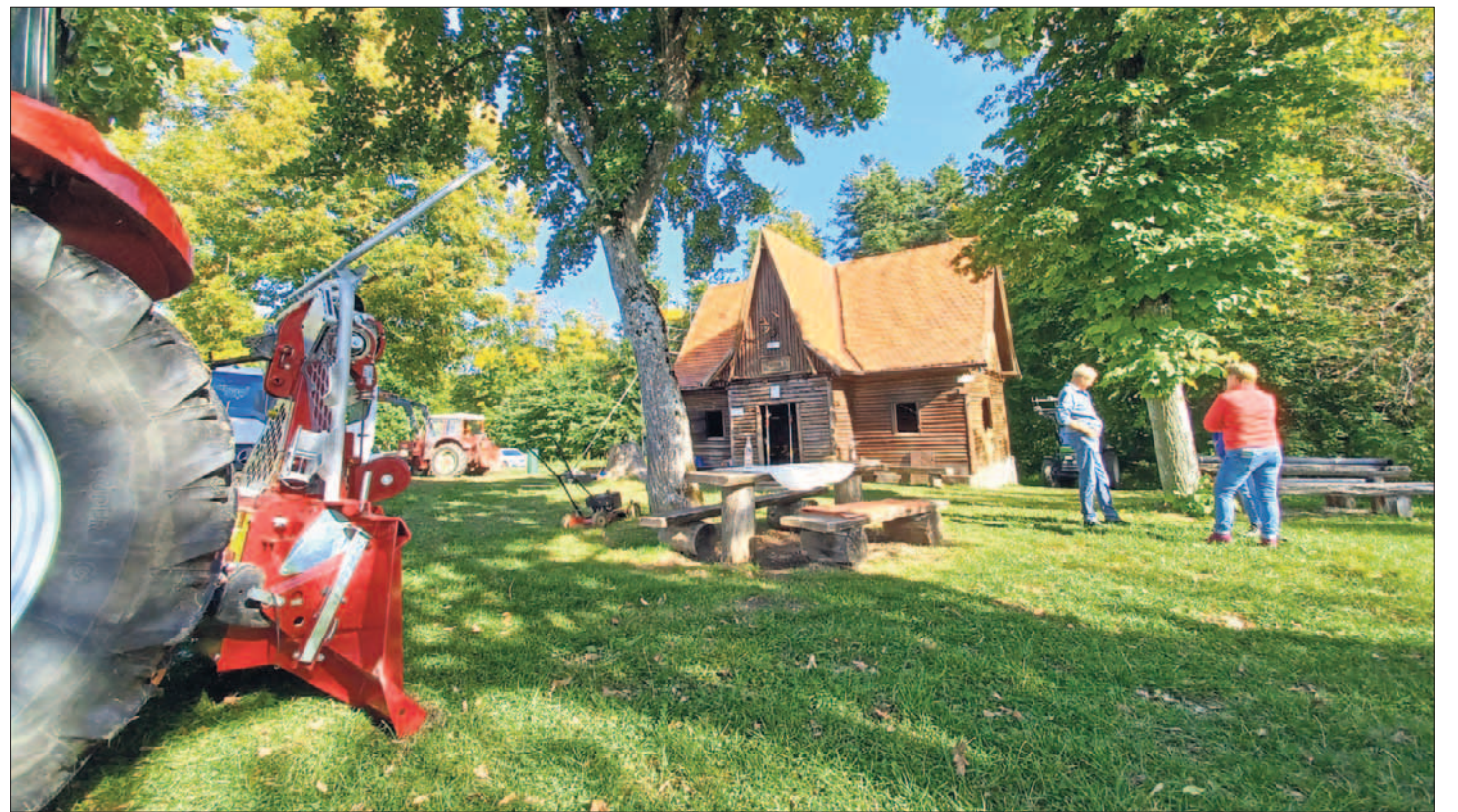
Die Schutzhütte auf dem Bolberg ist saniert worden. Das Häuschen war immer mehr in Schiefelage geraten.
